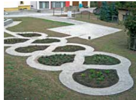
Nach dem Einbau
